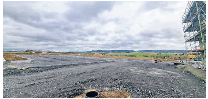
Außenarbeiten am neuen Schulhof der Grundschule Limespark
