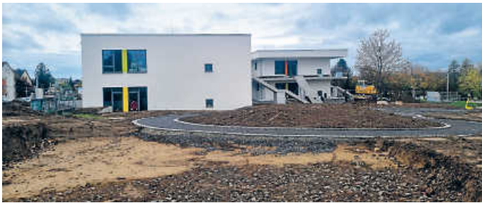
Finale Bauarbeiten am Kindergarten Friedenshort
