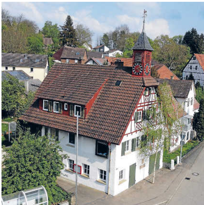
Das Rathaus in Cappel wird saniert und mit zwei Wohnungen als sozialer Wohnraum versehen. Die Verwaltungsstelle ist vorübergehend in die ehemaligen Räumlichkeiten der Raiffeisenbank in Cappel gezogen
