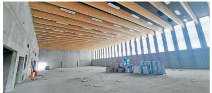
Die neue Doppelsporthalle der Grundschule Limespark
